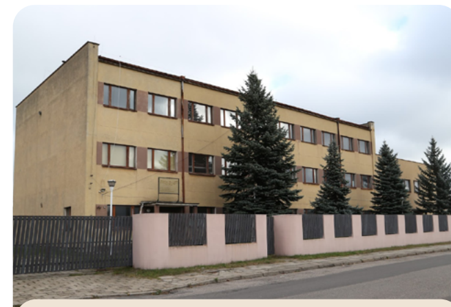
W Puszczkowie w grudniu 1977 roku zaczęto budowę nowego zakładu, którego mury do dziś stoją przy ulicy Niepodległości.
