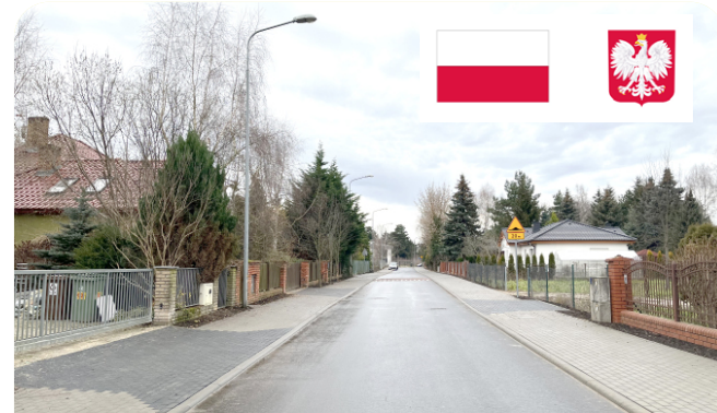
Przebudowa ul. Fiołkowej wraz z budową kanalizacji deszczowej - dofinansowanie ze środków Państwowego Funduszu Celowego (Rządowy Fundusz Rozwoju Dróg)
