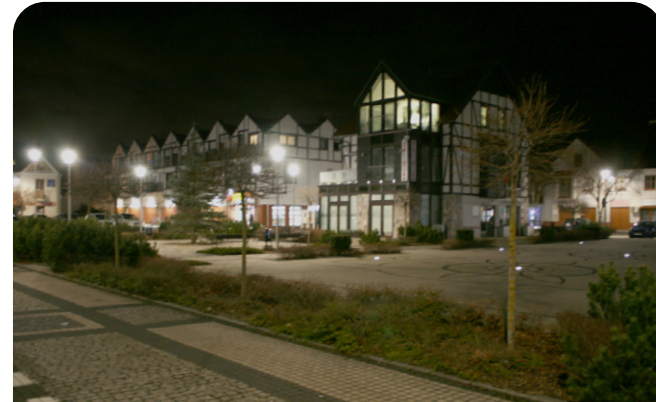
Wymiana wszystkich ulicznych lamp na Rynku na nowoczesne i energooszczędne oprawy LED
