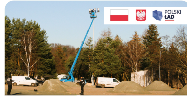
Budowa budynku zaplecza socjalno-sportowego wraz z modernizacją boiska piłkarskiego i budową oświetlenia - dofinansowanie ze środków Rządowego Funduszu Polski Łąć: Program Inwestycji Strategicznych (realizacja przez Bank Gospodarstwa Krajowego)
