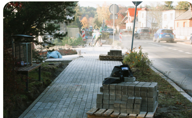
Budowa chodnika na ul. Dworcowej
