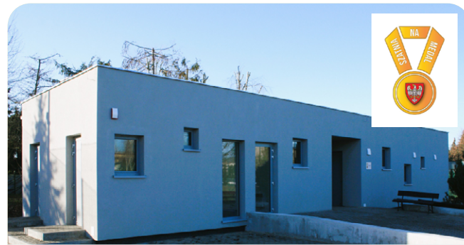
Budowa szatni na terenie sportowym Orlik przy ul. Nowe Osiedle - dofinansowanie ze środków samorządu Województwa Wielkopolskiego w ramach 5. edycji Programu „Szatnia na Medal”.
