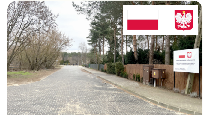
Budowa ul. Radosnej - dofinansowanie ze środków Państwowego Funduszu Celowego (Rządowy Fundusz Rozwoju Dróg)
