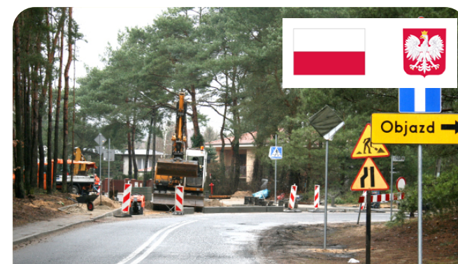
Budowa ul. Wspólnej - dofinansowanie ze środków Państwowego Funduszu Celowego (Rządowy Fundusz Inwestycji Lokalnych)
