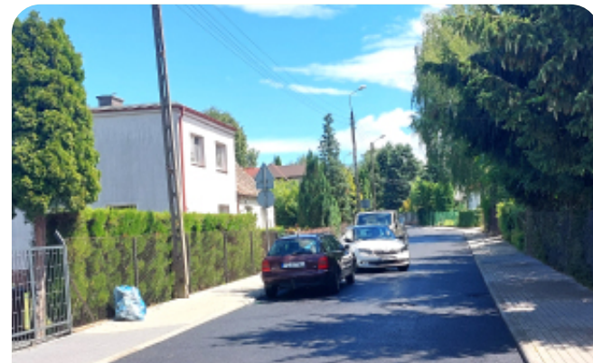
Budowa ul. Leśnej
