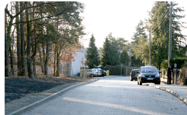
Budowa ul. Powstańców Wielkopolskich
