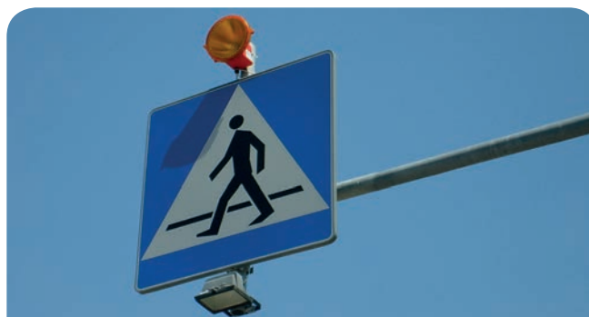
Aktywny znak drogowy D6 z lampą wczesnego ostrzegania oraz doświetleniem przejście
