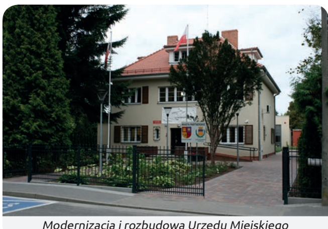
Modernizacja i rozbudowa Urzędu Miejskiego
