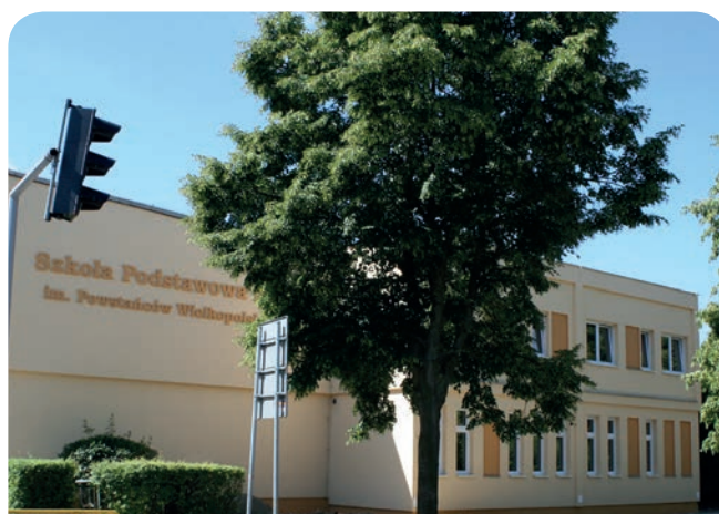
Rozbudowa SP 2 o sanitariaty
