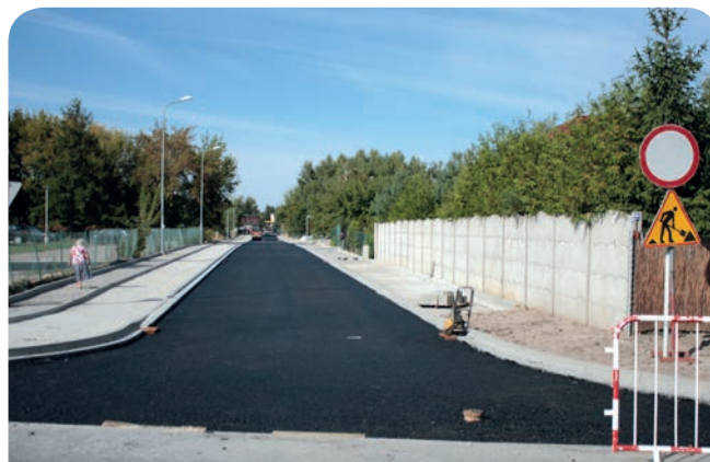
Budowa ulicy Szpitalnej
