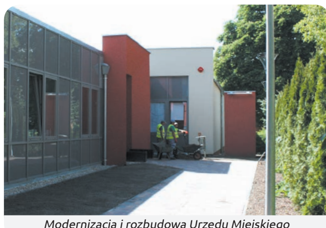
Modernizacja i rozbudowa Urzędu Miejskiego
