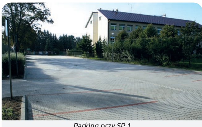
Parking przy SP 1
