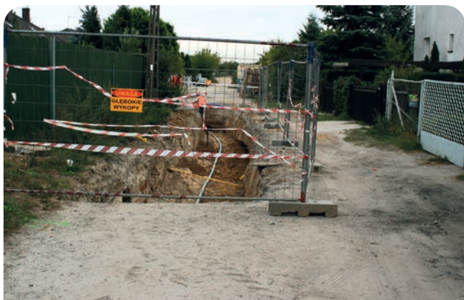
Budowa ulicy Klasztornej
