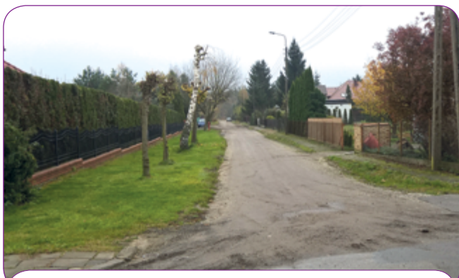
Budowę ul. Krańcowej zrealizuje Zakład Robót Drogowych Marek Dachtera.
