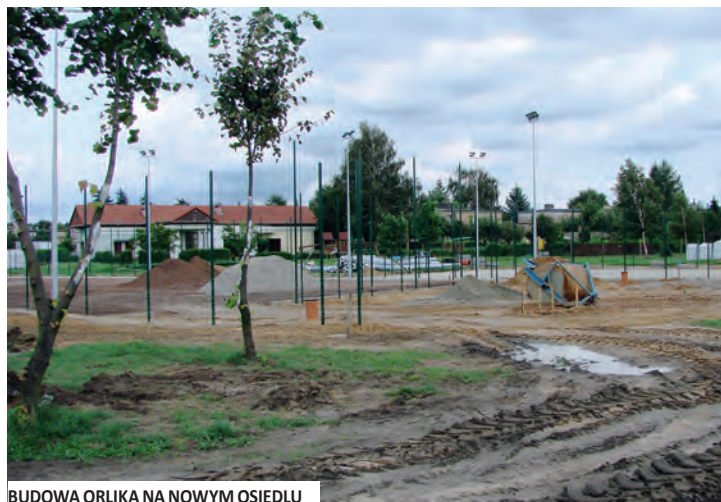
BUDOWA ORLIKA NA NOWYM OSIEDLU
