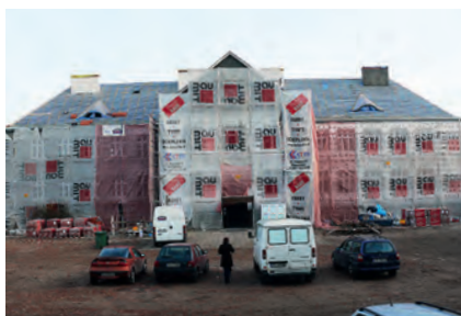
LISTOPAD: REMONT I ADAPTACJA BUDYNKU PRZY UL. WYSOKIEJ 1
