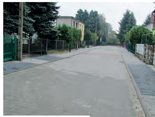
PAŹDZIERNIK: BUDOWA UL. NORWIDA
