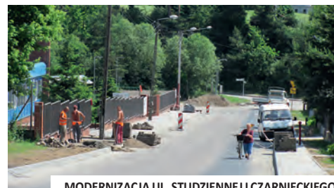
MODERNIZACJA UL. STUDZIENNEJ I CZARNIECKIEGO
