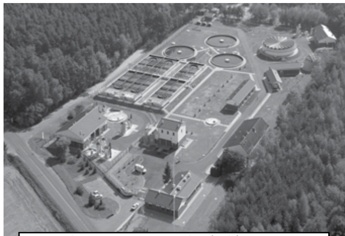
Zmodernizowana Oczyszczalnia ścieków w Mosinie
