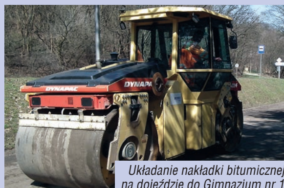
Budowa chodnika na ul. Sobieskiego
