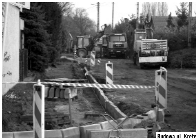
Budowa ul. Krętej
