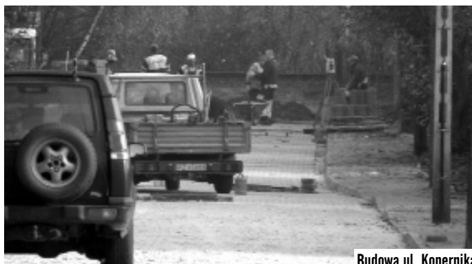
Budowa ul. Kopernika
