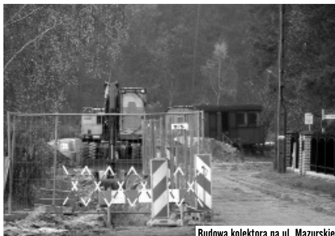
Budowa kolektora na ul. Mazurskiej
